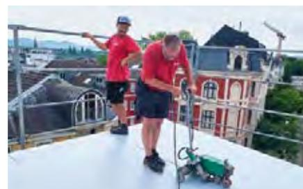
„Lupendichte“ Nahtfügung der Dachbahnen mittels Heißluft-Schweißautomat
