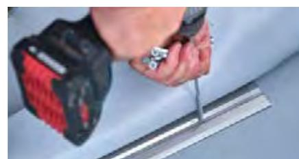
Die Montageschiene wird mit zugelassenen Dachbauschrauben in der Tragschicht verankert
