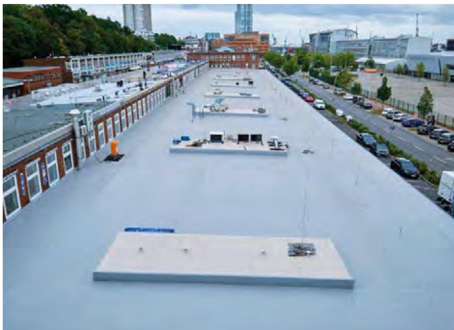
**Inbesondere bei großen Flächen und hochsommerlichen Temperaturen glänzt die weiterentwickelte Kunststoffabdichtungsbahn durch deutlich reduzierte Faltenbildung**
