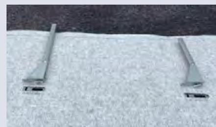
Vorgefertigte Öffnungen mit Pfeilausschnitt im Wasserspeicherelement zeigen die exakte Position und Ausrichtung für die Stützenmontage an
