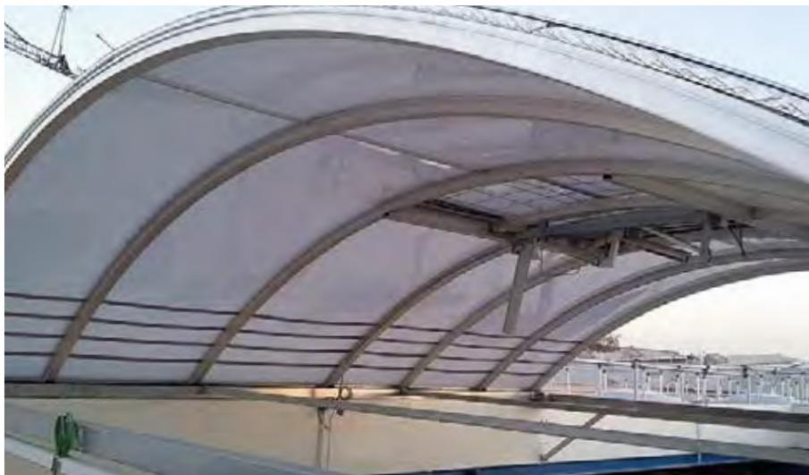
Zum Einsatz kam das Kingspan ESSMANN Lichtband basic mit pneumatischem NRW F6 sowie Ab- und Durchsturzsicherungen ID 1200 und EAD
