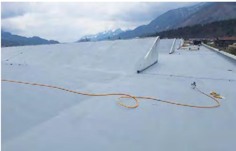
Die Spritztechnik eignet sich zum einen für große Flächen, zum anderen optimiert es die Verarbeitung bei speziellen Dachteilen, beispielsweise Dachfenstern
