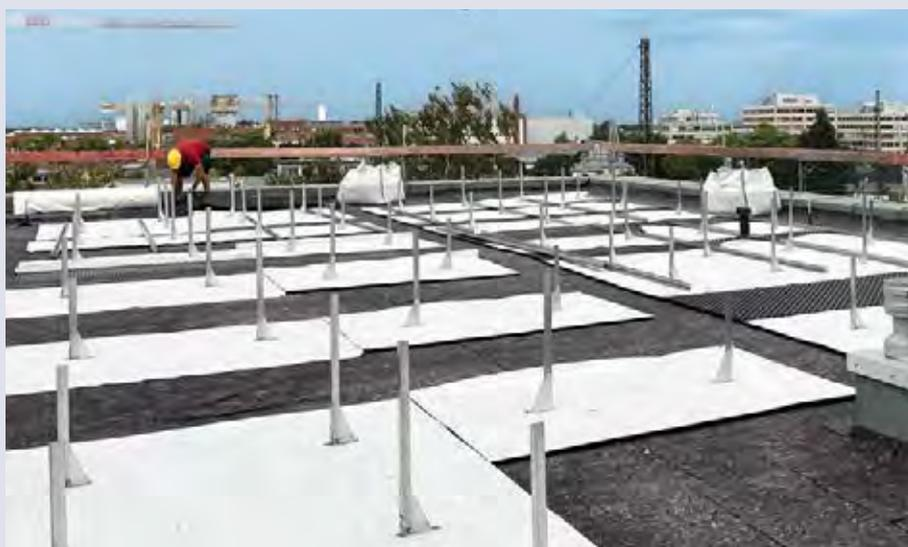
Auf den zum PV-System gehörenden Wasserspeicherplatten ist das Vlies bereits aufkaschiert. In den Zwischenräumen werden die nach Bedarf zugeschnittenen Speicherelement-Platten und das Filtervlies aus dem SOPREMA Gründachsystem verlegt.
