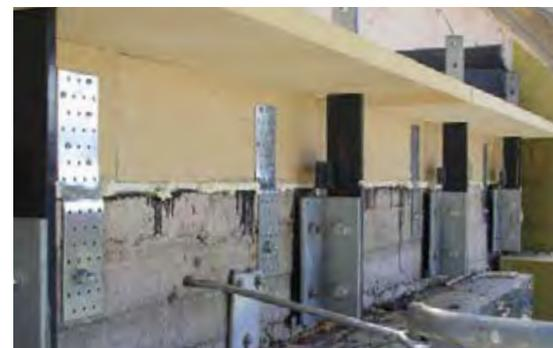
auf, was ihm im konstruktiv anspruchsvollen Bereich der Attika den besten Wärmeschutz verleiht. Zusätzlich sind die Attikaelemente bereits mit einem 5°-Gefälleschnitt für eine sichere Wasserableitung versehen, was die Installation erheblich erleichtert. Dank vorgefertigter Profile lassen sich die Phonotherm® Attikaelemente in kurzer Zeit und ohne großen Aufwand verarbeiten.
